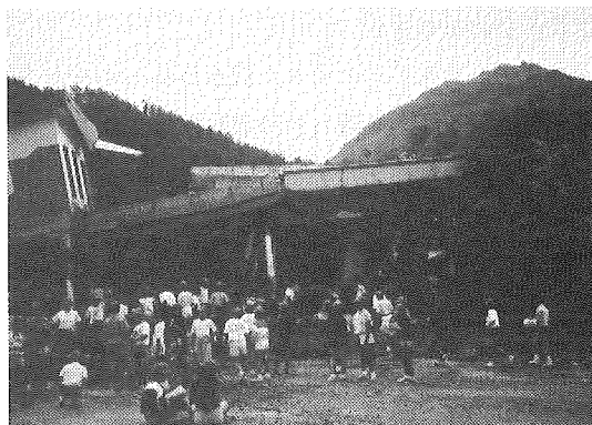
三恵病院が破壊された様子
